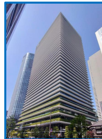
虎ノ門ヒルズ ビジネスタワー
