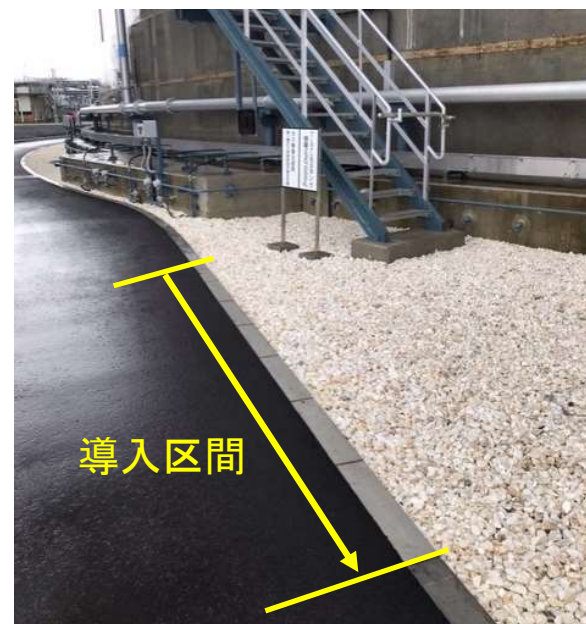
当社日立LNG基地に導入
